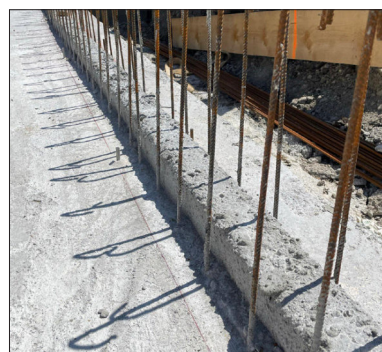
Betonfeder für Aufkantungungen Typ 2
